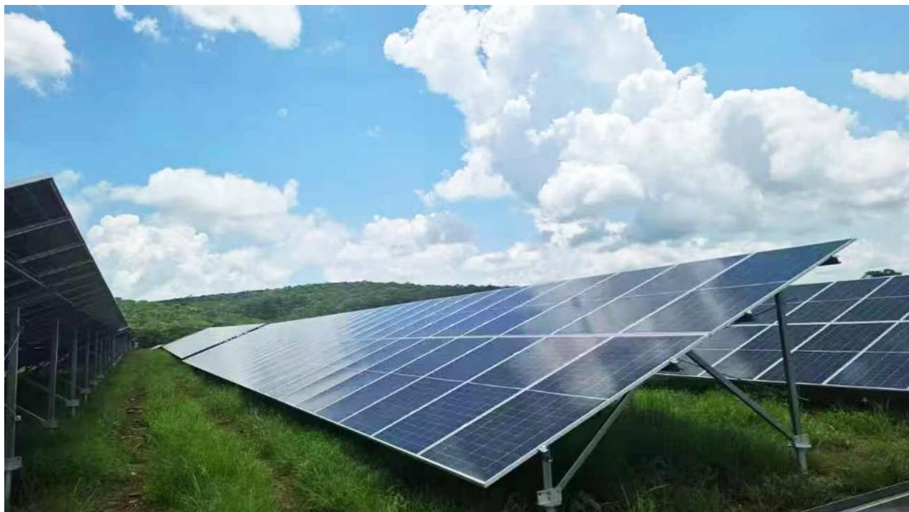
Kitumba 一期 50 兆瓦光伏电站
