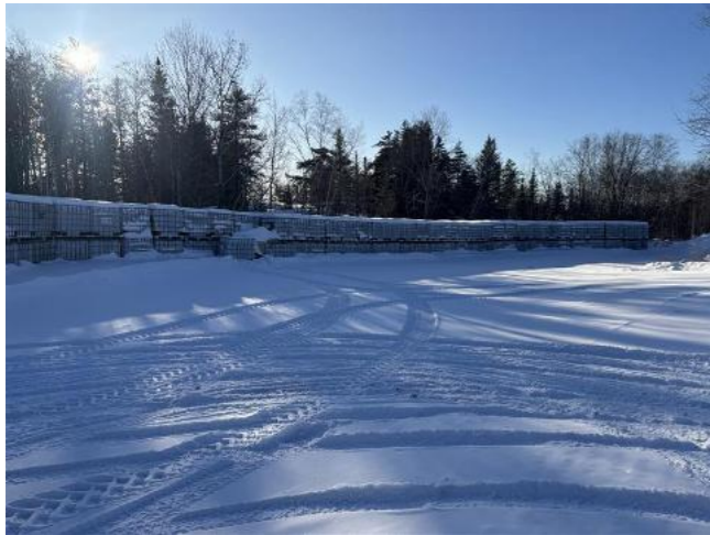
Tanco 固体废物转移站
