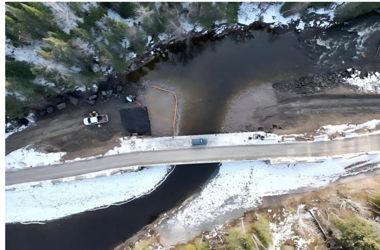
Tanco 矿山大桥
